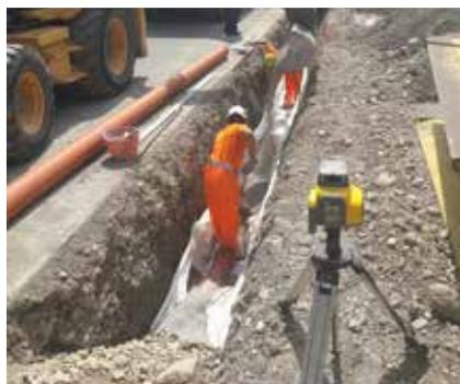
A sinistra: cantiere di espansione della rete di acque nere in un comune in provincia di Treviso. Il tubo utilizzato è MonoPiPe+.
