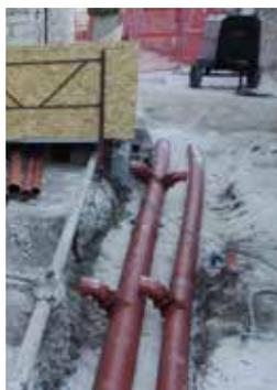
A sinistra: ispezione lineare realizzata con Simple Crown e innesti di nuove utenze su linea fognaria realizzati con Simple Crown
