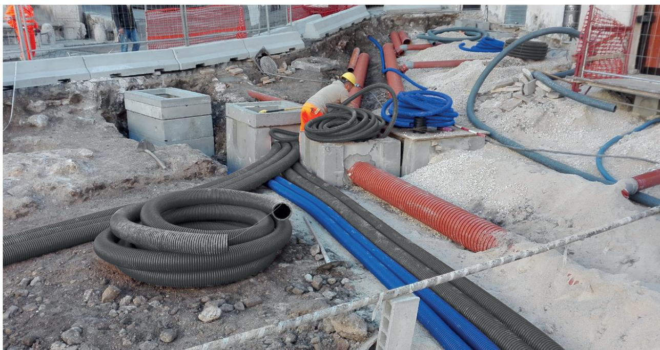
Sopra, immagine di **corrugar** in cantiere: si possono vedere tubi di colore grigio e tubi blu usati prevalentemente per il passaggio dei cavi telefonici (il cosiddetto "doppino"). Sono visibili anche alcune barre di tubi in polipropilene alto modulo PPHM (KINGCOR Riccini)
