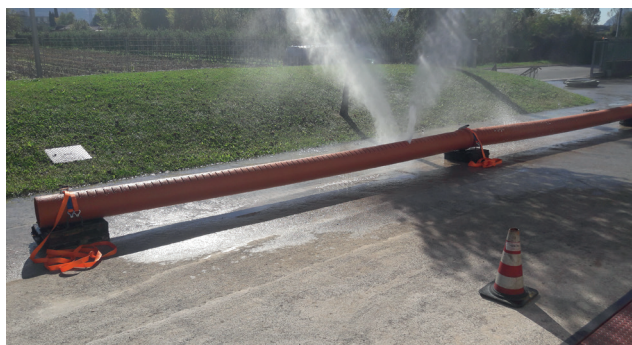
Pulizia effettuata con lavaggio ad alta pressione
