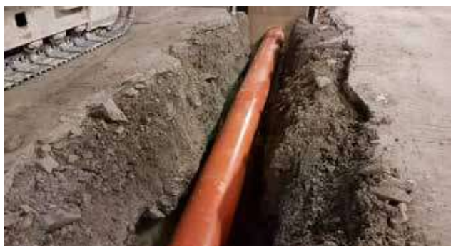
Una fase di installazione di MonoPiPe+ in trincea
