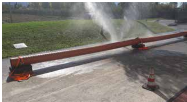
Pulizia effettuata con lavaggio ad alta pressione
