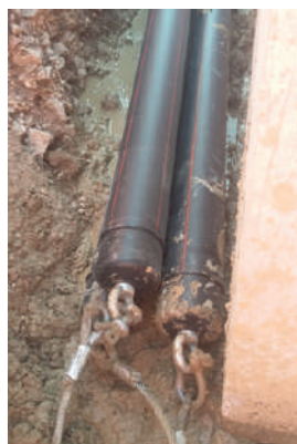
Qui sopra: quattro immagini di una installazione di CAVIDOTTO redline HDPE
