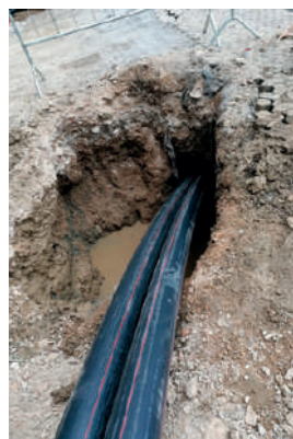
Qui sopra: quattro immagini di una installazione di CAVIDOTTO redline HDPE
